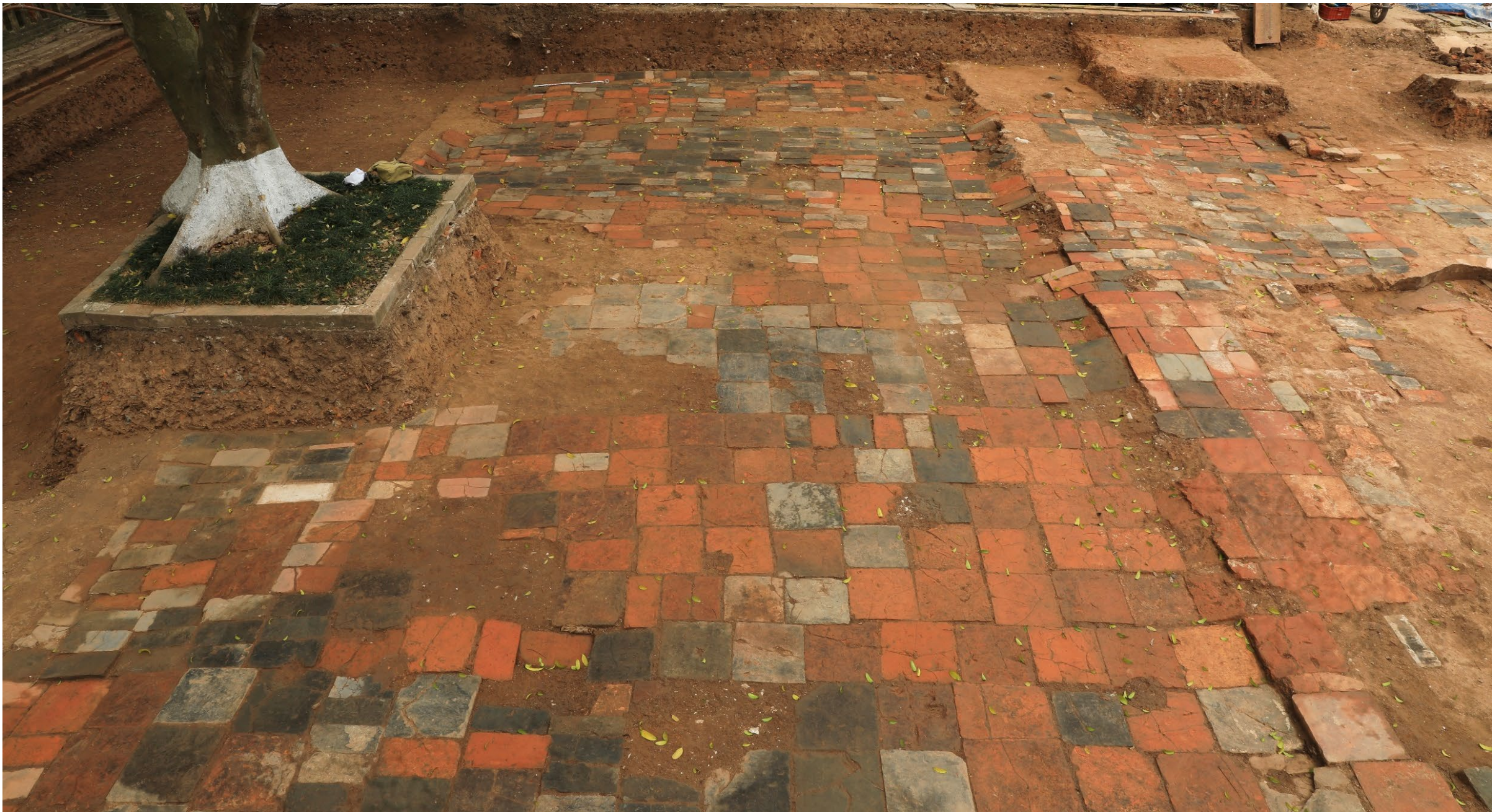
Dấu vết sụt lún của sân điện Kính Thiên
