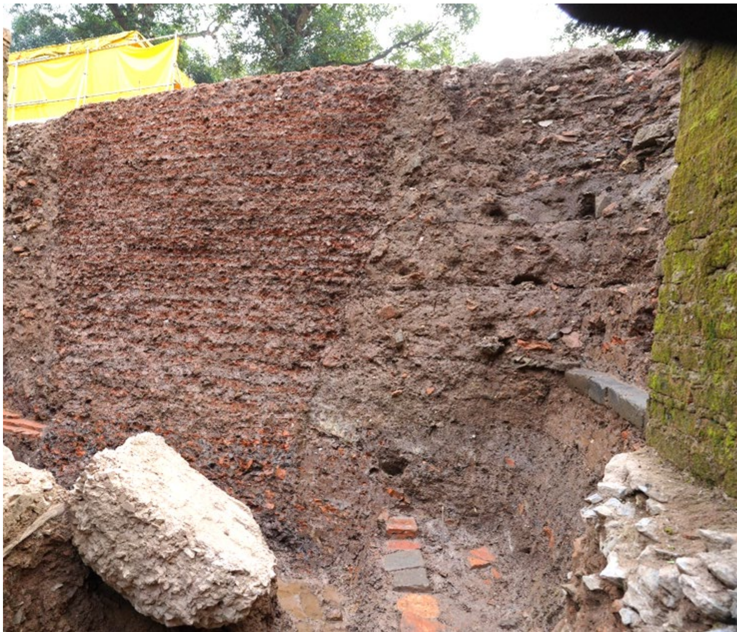
Cấu trúc móng cột D1-2 điện Kính Thiên, thời Lê 81 lớp đầm, cao 4m
